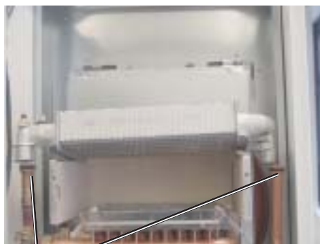
Демонтировать зажимные клипсы [10] Рис: Демонтаж теплообменника сетевой воды
